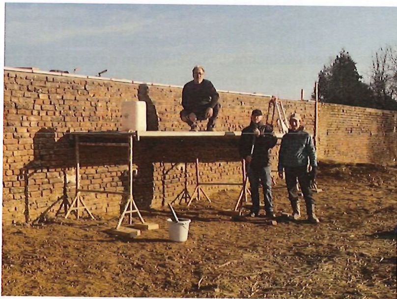
Réfection du mur de l'enceinte de la future Salle de sport
